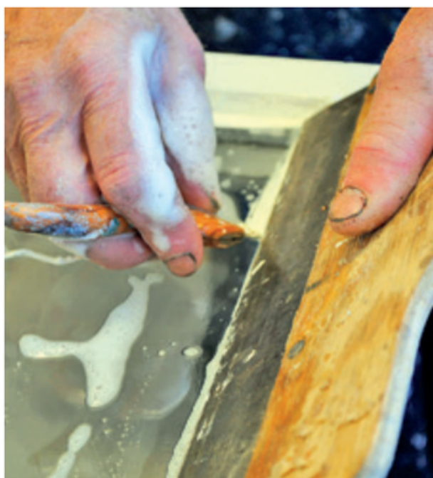
Recorta los bordes de la masilla pintada con una solución suave de agua y jabón.
