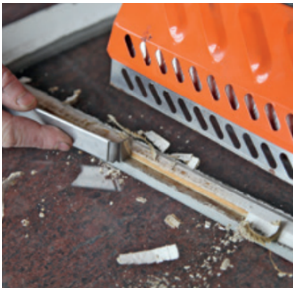
Lámpara de masilla para eliminar masilla. También puede utilizarse para eliminar pintura hasta cierto punto.
