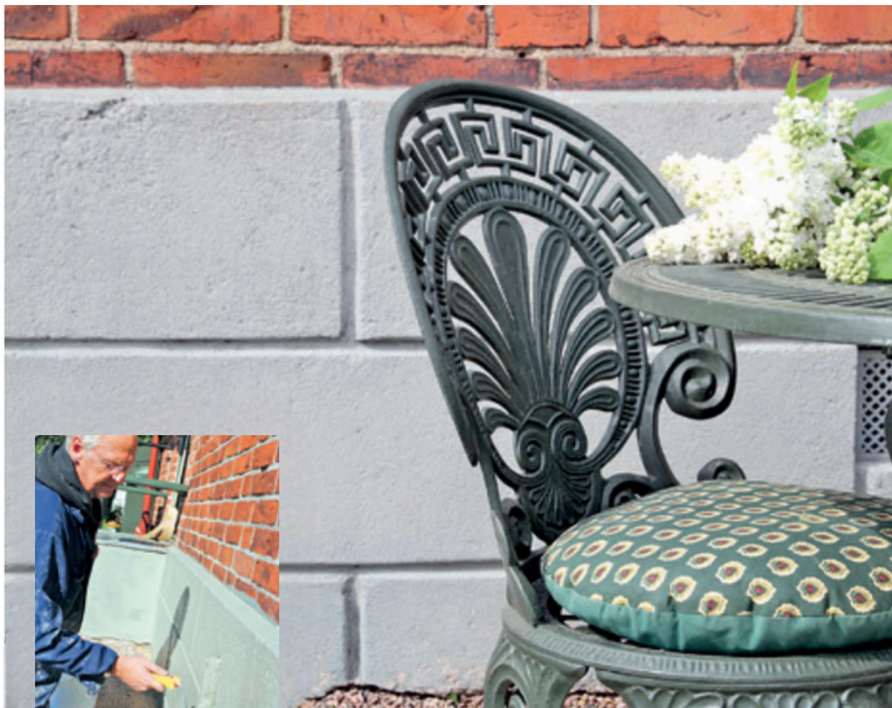
Mantenimiento de la base 20 años después de pintar con pintura en emulsión
