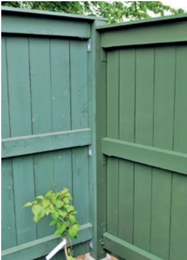
Primera y segunda capa. ¡TERMINA LA PINTURA! Al menos tres capas completamente cubrientes.
