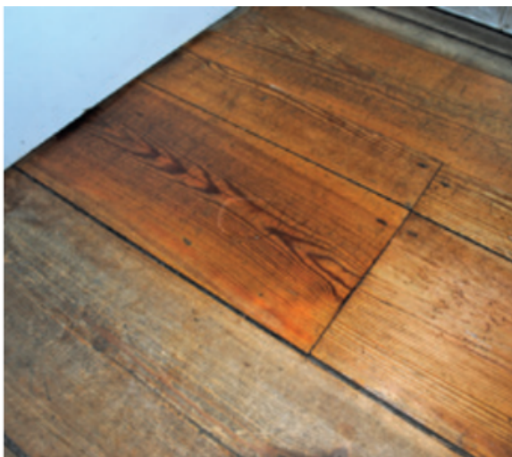
Cera de linaza natural utilizada en madera antigua. Antes/después del tratamiento.
